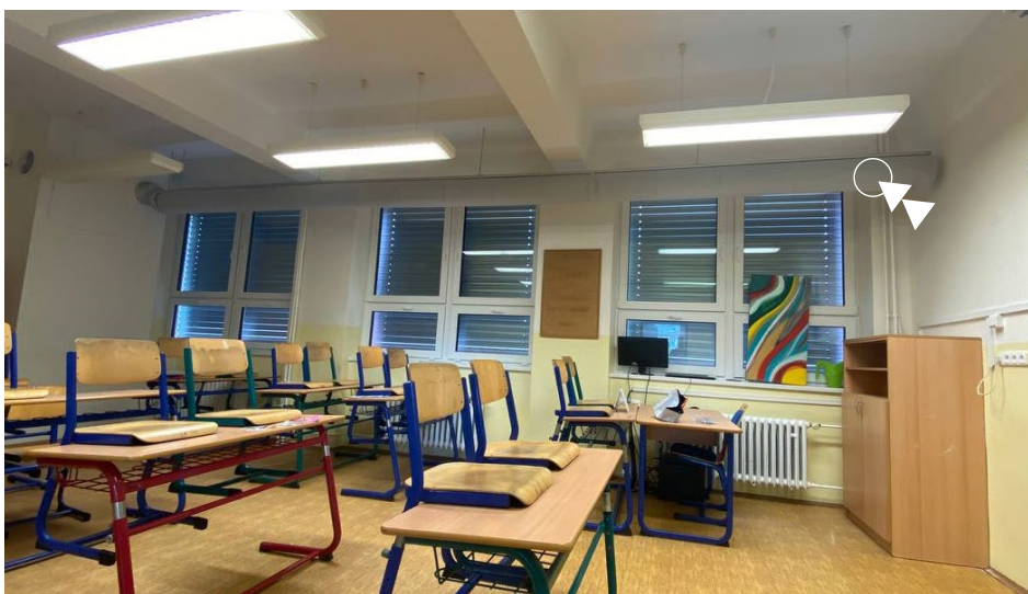
Lokální jednotka ve třídě s textilní vyústkou – řízený přívod čerstvého vzduchu
