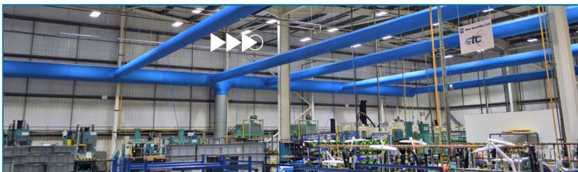
Un elevato numero di ricambi d'aria è condizione necessaria per il trattamento dell'aria contaminata da sostanze tossiche. La distribuzione dell'aria stessa con un sistema tradizionale di condotti rigidi è costoso e può generare correnti d'aria, corrodersi ed essere troppo pesante. La distribuzione dell'aria attraverso un diffusore tessile ne consente una diffusione uniforme, che difficilmente può essere garantita da altri sistemi.
