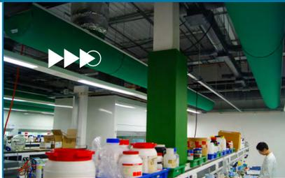
Un elevato numero di ricambi d'aria è condizione necessaria per il trattamento dell'aria contaminata da sostanze tossiche. La distribuzione dell'aria stessa con un sistema tradizionale di condotti rigidi è costoso e può generare correnti d'aria, corrodere ed essere troppo pesante. La distribuzione dell'aria attraverso un diffusore tessile ne consente una diffusione uniforme, che difficilmente può essere garantita da altri sistemi.
